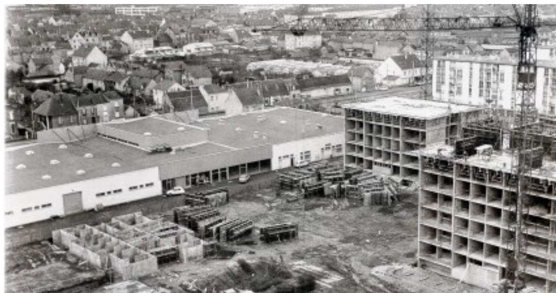
La construction des premiers immeubles va débuter en 1969.
